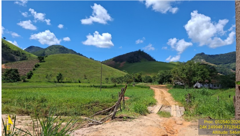
Figura 1: Vistoria técnica Consórcio Caparaó. Atividade: terraplanagem. Local: Zona Rural de Muniz Freire – ES.
