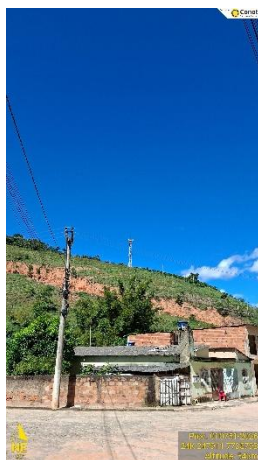
Figura 4: Vistoria técnica Consórcio Caparaó. Atividade: A-21 - Estação de Telecomunicação. Local: Muniz Freire – ES.
