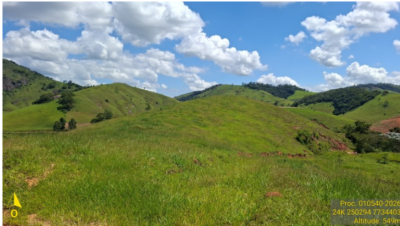
Figura 2: Vistoria técnica Consórcio Caparaó. Atividade: terraplanagem. Local: Zona Rural de Muniz Freire – ES.
