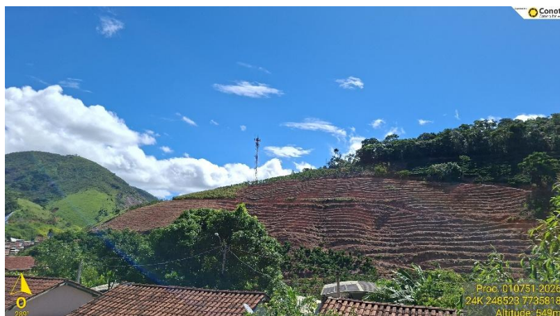
Figura 3: Vistoria técnica Consórcio Caparaó. Atividade: A-21 - Estação de Telecomunicação. Local: Muniz Freire – ES.
