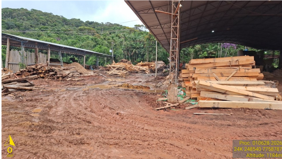
Figura 1: Vistoria técnica Consórcio Caparaó. Atividade: Comércio de Eucalipto. Distrito de Alto Norte, Muniz Freire – ES.
