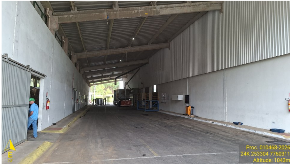
Figura 3: Vistoria técnica Consórcio Caparaó. Atividade: Renovação de Licença de Municipal Simplificada Estocagem de grãos. Local: Muniz Freire – ES.
