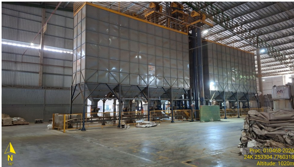
Figura 4: Vistoria técnica Consórcio Caparaó. Atividade: Renovação de Licença de Municipal Simplificada Estocagem de grãos. Local: Muniz Freire – ES.
