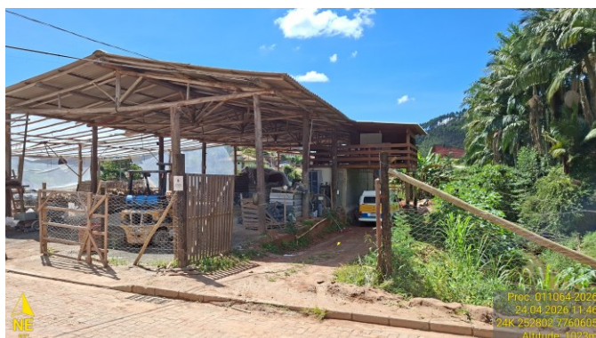
Figura 4: Vistoria técnica Consórcio Caparaó. Atividade: Fábrica de pré-moldados em concreto armado e sob encomenda. Local: Muniz Freire – ES.
