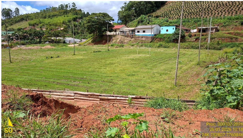
Figura 3: Vistoria técnica Consórcio Caparaó. Atividade: Terraplanagem para acerto do terreno de campo de futebol – BOM de Bola. Local: Assunção, Muniz Freire – ES.
