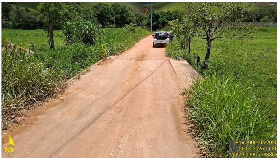
Figura 2: Vistoria técnica Consórcio Caparaó. Atividade: Construção de 02 pontes – Ponte 2.
