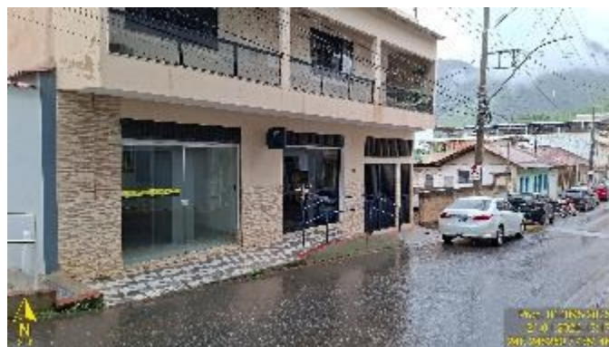
Figura 3: Vistoria técnica Consórcio Caparaó. Atividade: EDP.
