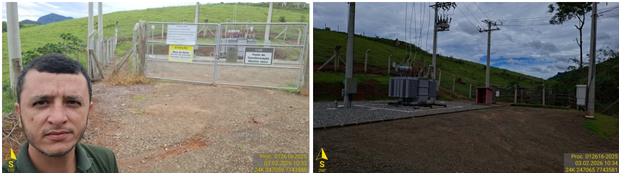
Figura 4: Vistoria técnica Consórcio Caparaó.
