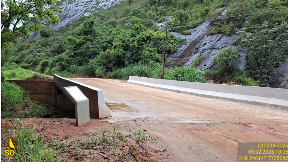
Figura 1: Vistoria técnica Consórcio Caparaó. Atividade: Construção de Ponte em rodovia ES 379. Zona Rural de Muniz Freire – ES.
