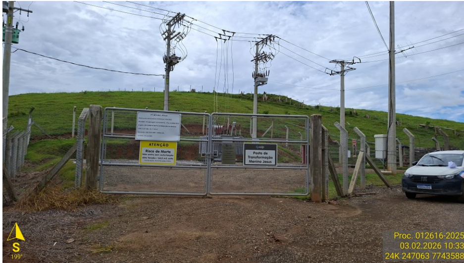
Figura 3: Vistoria técnica Consórcio Caparaó.
