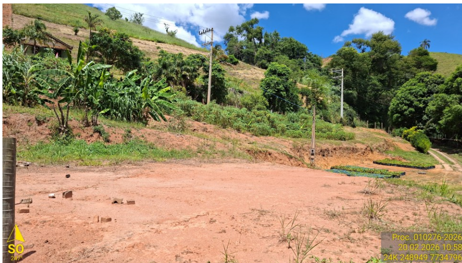
Figura 2: Vistoria técnica Consórcio Caparaó. Atividade: terraplanagem. Distrito de Alto Norte, Muniz Freire – ES.
