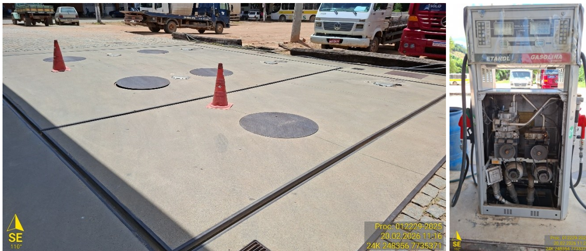
Figura 4: Vistoria técnica Consórcio Caparaó. Atividade: Renovação de Licença de Municipal de Operação Posto de Combustível. Local: Muniz Freire – ES.
